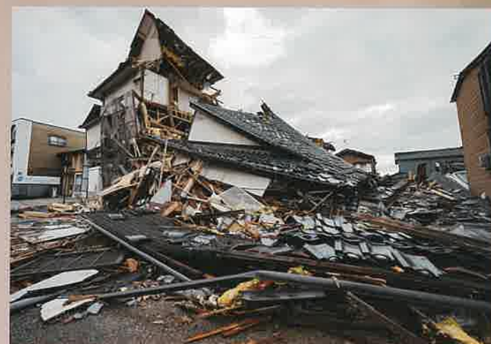
全壊した木造家屋(輪島市)
