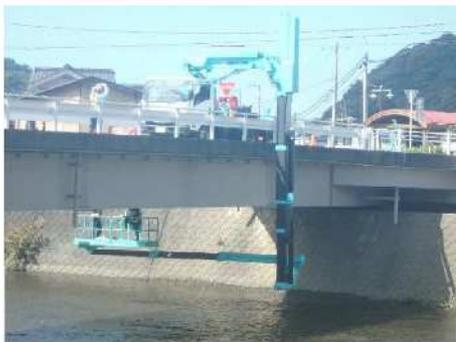
築地橋 橋梁点検車による点検状況
