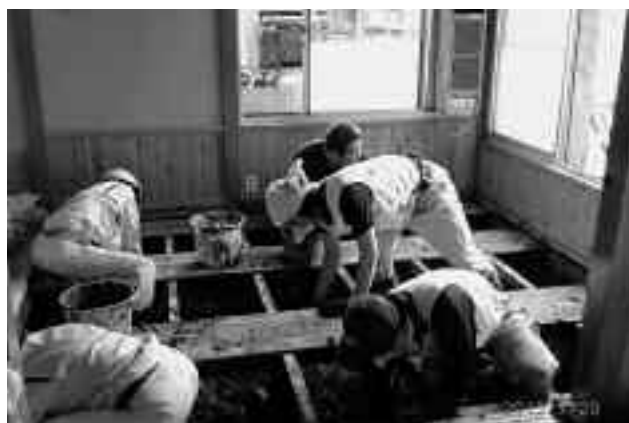
▲床下に入り込んだ土砂を撤去するボランティア
