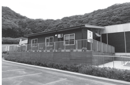
黄金崎クリスタルパーク改修工事
