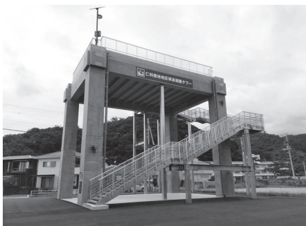
仁科築地地区津波避難タワー建設工事
