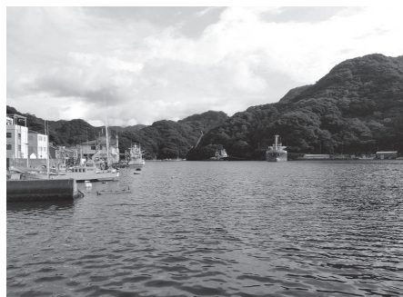
安良里漁港浚渫工事
