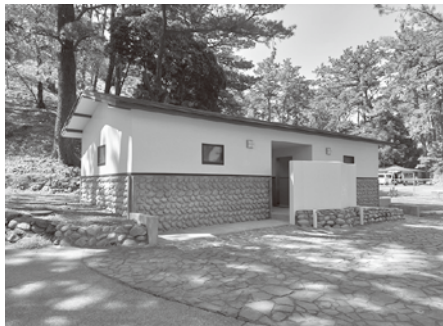
黄金崎公園芝生広場公衆トイレ改修工事
