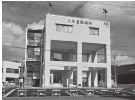
仁科浜地区津波等避難施設建設工事
