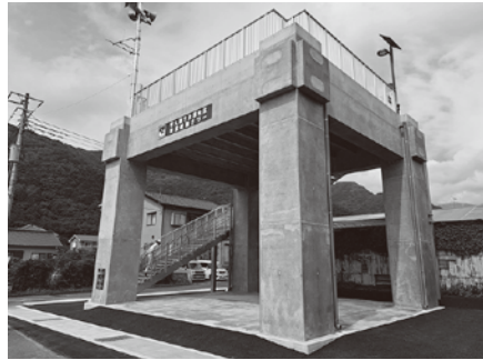
津波避難タワー整備工事(宇久須) (繰り越しをしたため6月完成)
