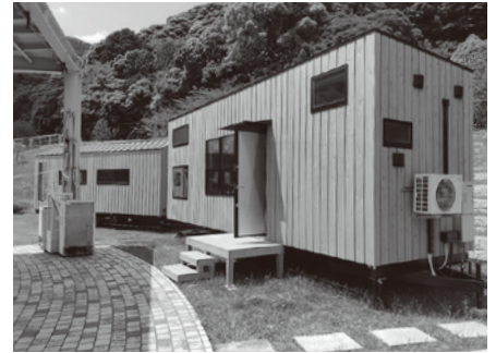
ワーケーション施設の整備 (トレーラーハウス)
