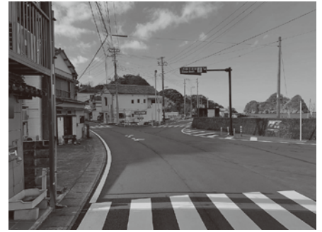
田子安良里線舗装補修工事
