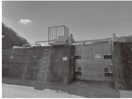
津波防災ステーション工事
