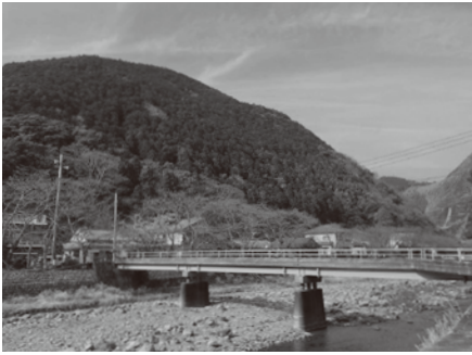
橋梁長寿命化対策工事（大下橋）
