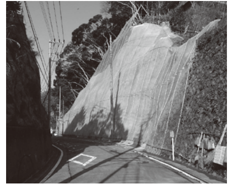
田子安良里線法面改修工事
