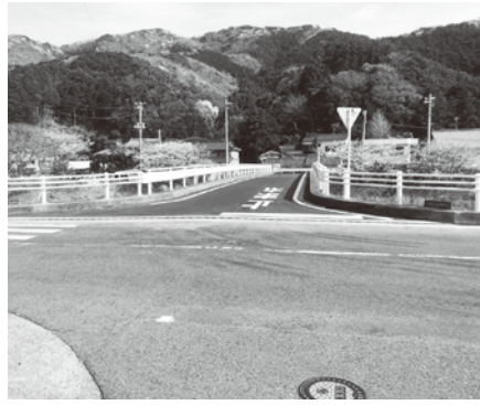
築地橋の長寿命化工事
