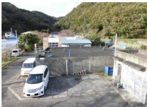
(先川浄水場 浄水池・着水池)
