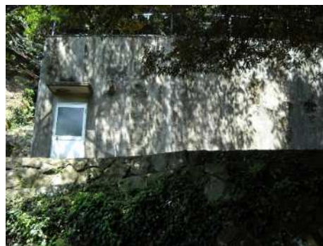
(田子高区配水池)
