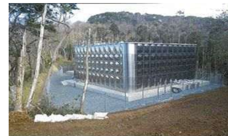
新正円配水池 (1300m 3 )
