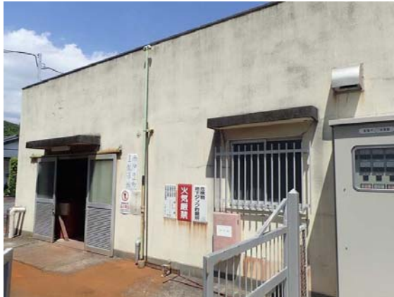
堂ヶ島主配湯所ポンプ室
