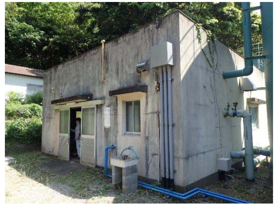
堂ヶ島副配湯所ポンプ室
