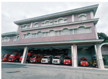
下田消防本部庁舎
