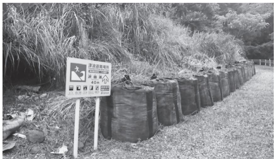
町道、私道に限らず、町内の避難路の安全性は
