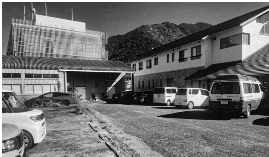
宇久須津波避難タワー建設予定地（浜地区）
