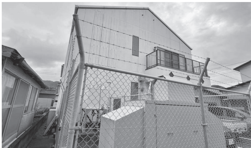
津波浸水区域内の電算センターと発電施設
