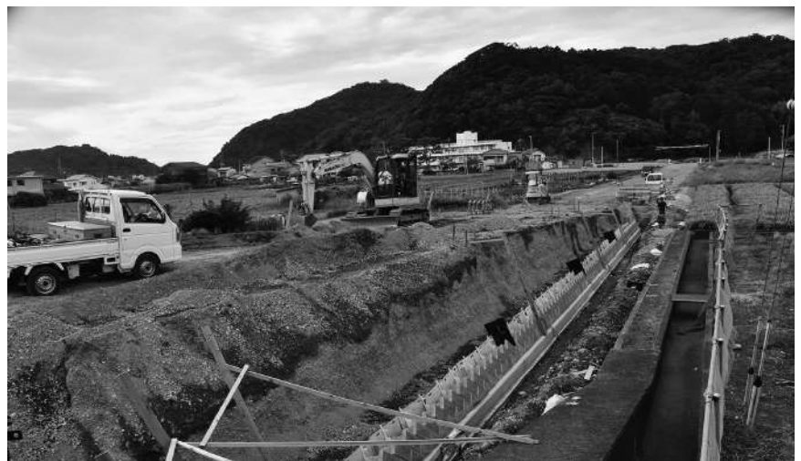
旧西伊豆中学校前道路を仮設から本設へ
