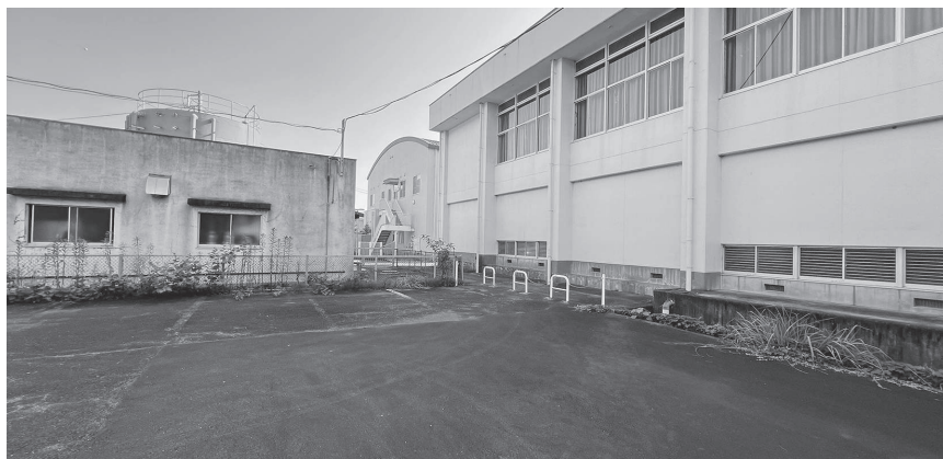
バイオマス発電設置仁科予定地（役場増進センター裏）
