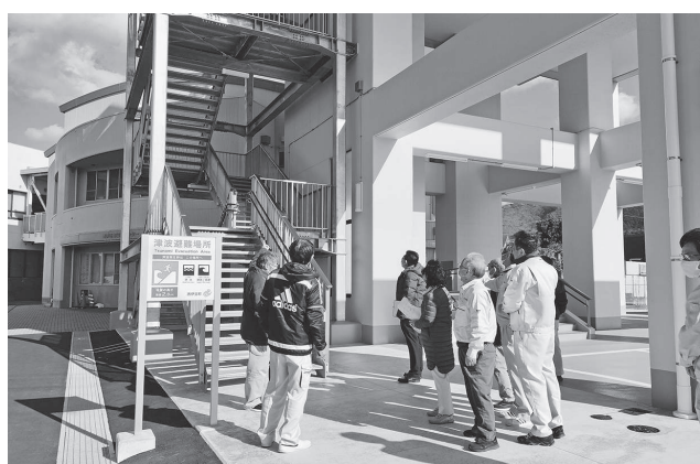
修繕が完了した仁科浜地区津波等避難施設
