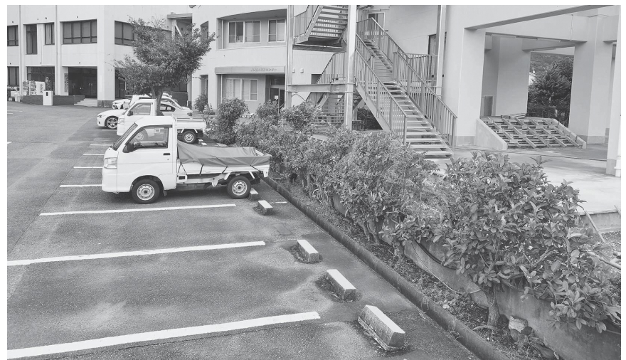
本庁舎駐車場を改修します
