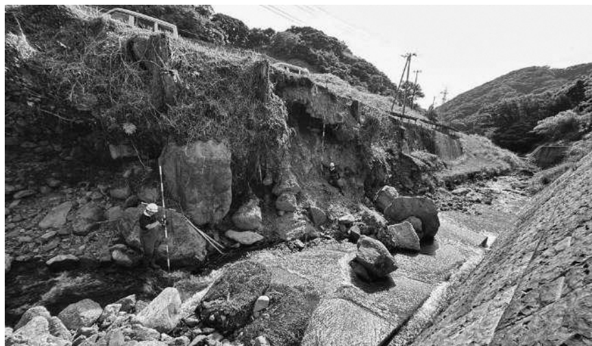
しっかりとした復旧工事を
