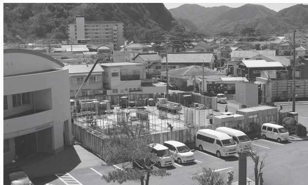
建設中の仁科浜地区津波等避難施設 第2常任委員長 浅賀 元希
