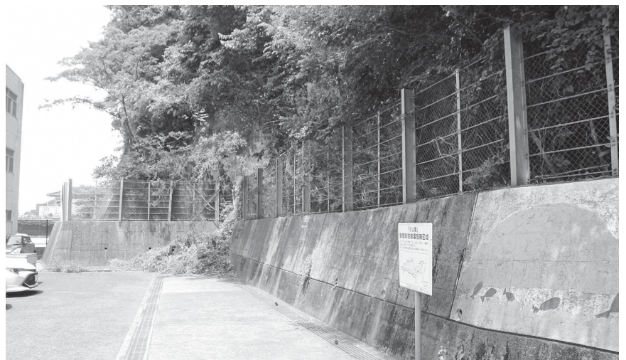
開発許可を左右する急傾斜地対策施設は十分か？
