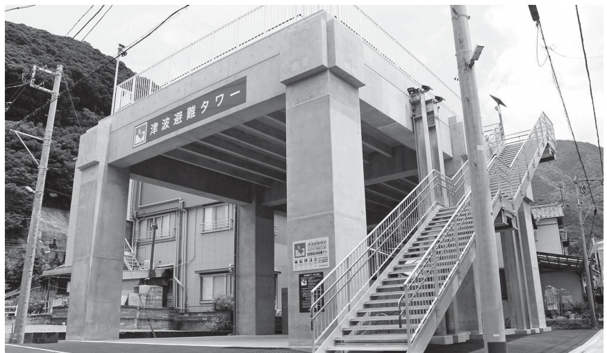
いざと言う時のための「安良里地区津波避難タワー」
