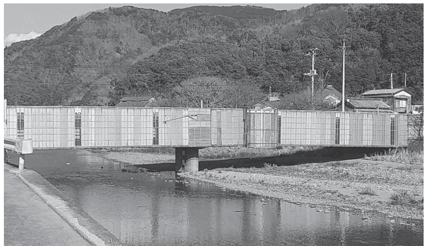
築地橋の長寿命化工事
