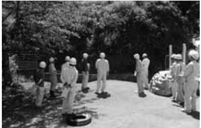
伊豆海認定こども園法面工事
