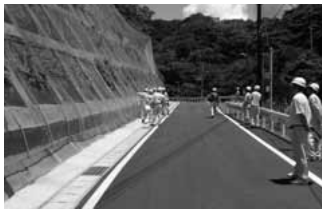
浮島新線法面改良工事
