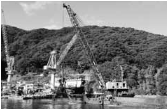
漁港内航路浚渫工事
