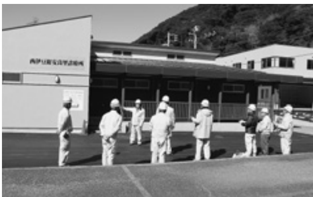
西伊豆町安良里診療所新築工事
