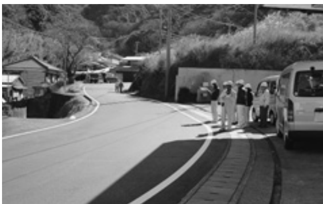
防災・安全交付金事業 (町) 田子安良里線改修工事
