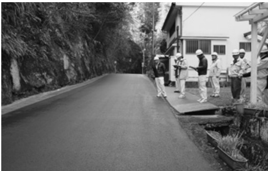
過去に何回も表層工が行われた箇所(通称浮島トンネル田子側)
