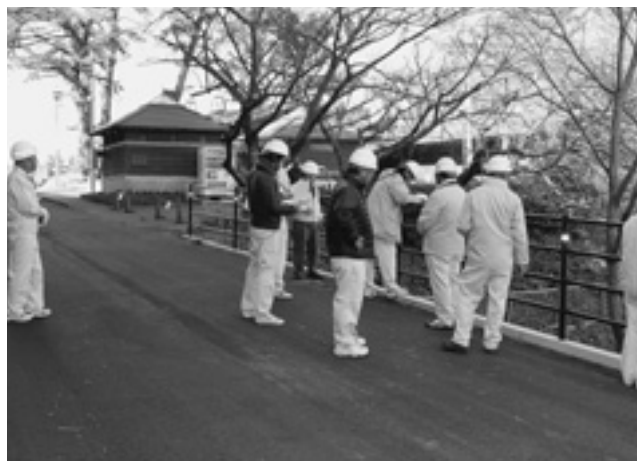
(町) 黄金崎柴線改修工事
