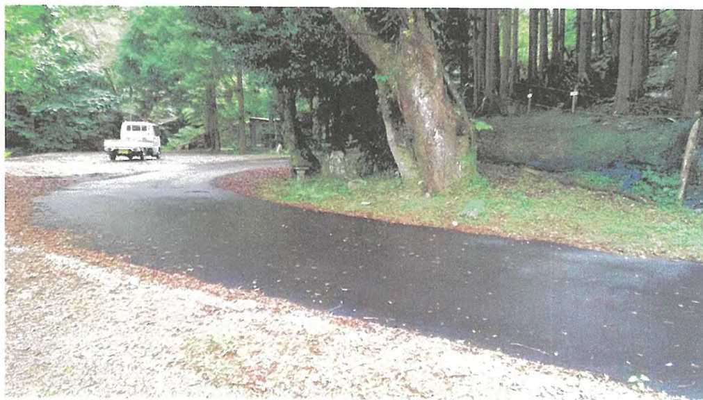
(舗装された町道大沢里線 大久須地内)
