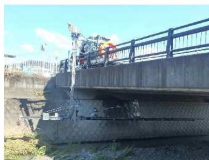
新技術による点検実施例
