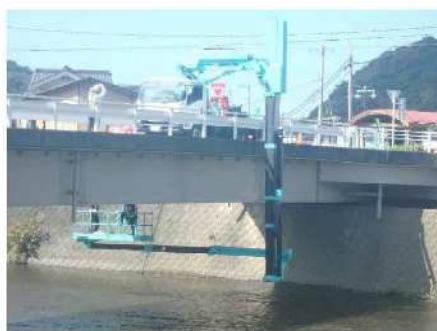
築地橋 橋梁点検車による点検状況
