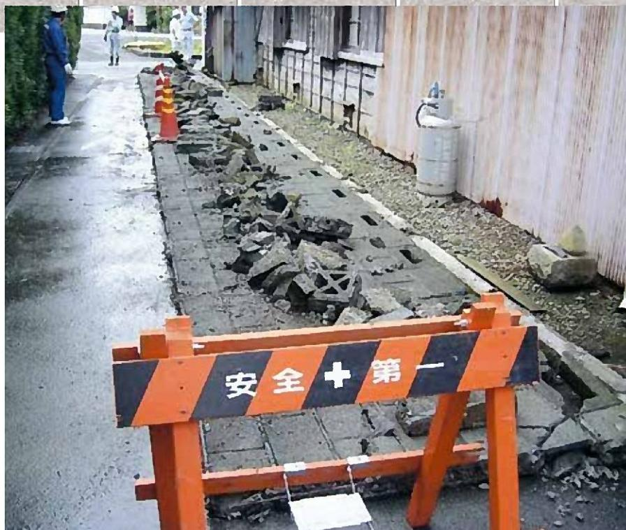
駿河湾を震源とする地震（平成 21 年 8 月 11 日発生）によるブロック塀の倒壊
