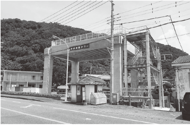
仁科浜地区津波避難タワー
