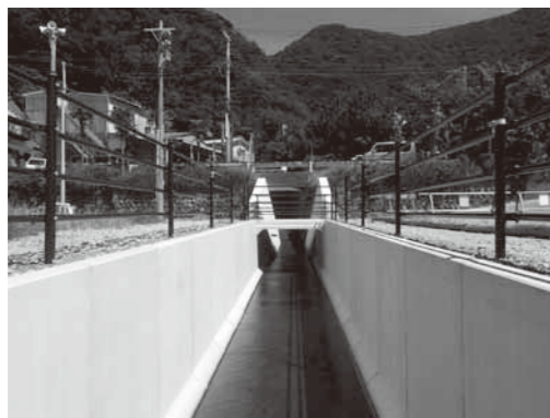
坂本川改修工事
