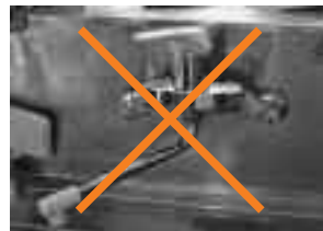
パッキン交換できない
