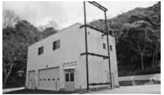
完成した第3分団詰所
