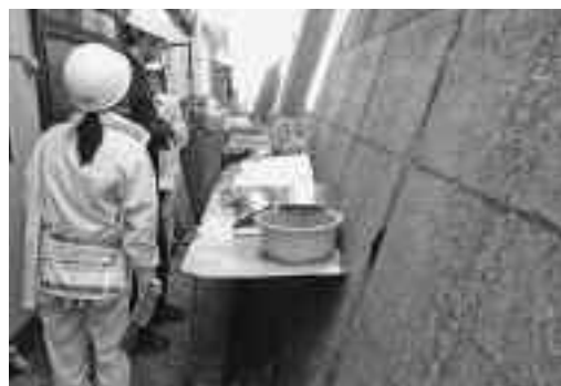
側溝の上に物が置かれている状況
