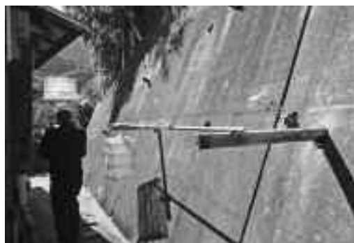
水抜きパイプに竹を差し込み、 物干しとして使用してる状況
