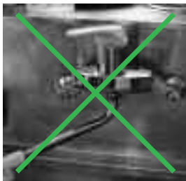
パッキン交換 できない
