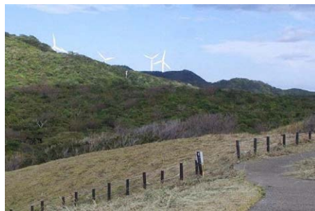
石廊崎風力発電所
