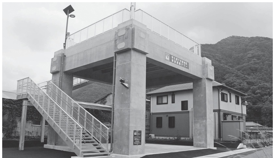
一人でも多くの犠牲者を減らす津波避難タワー（宇久須下月原地区）
