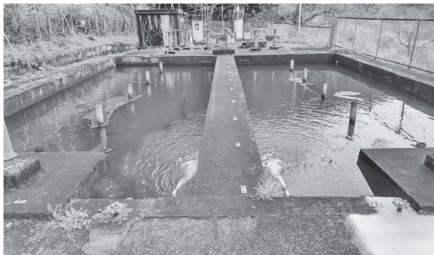
老朽が進む井野浄水場
