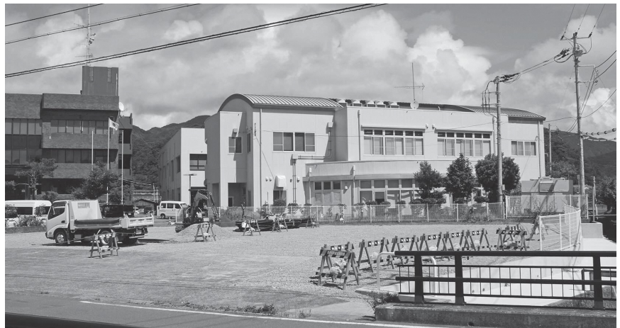
津波から町民を守る(旧西伊豆消防署跡地)
