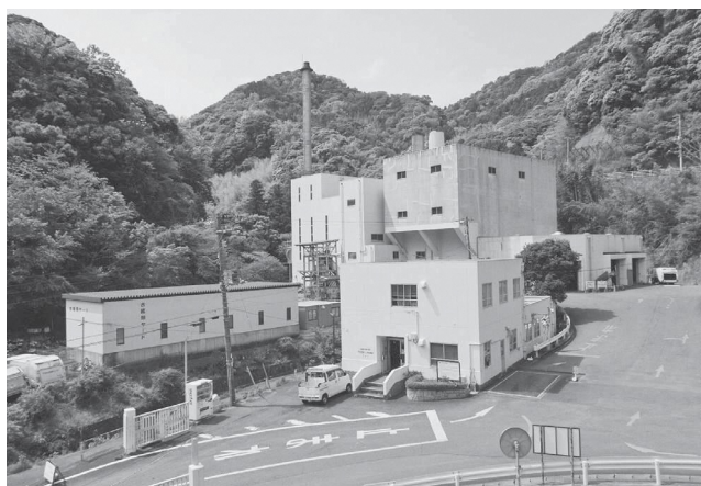
広域ごみ処理施設の建設候補地
