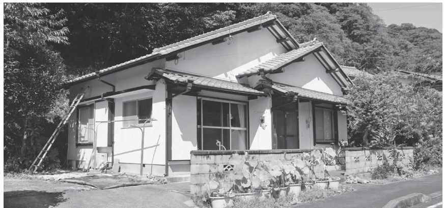
お試し住宅はコロナの影響で利用者がほぼいない状況
