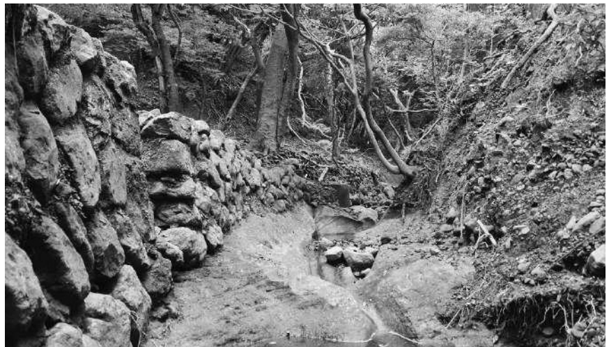
氾濫した三堂川上流
