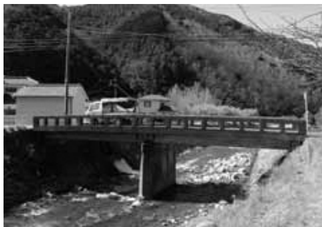
計画に沿った長寿命化対策工事を(大久須橋)
