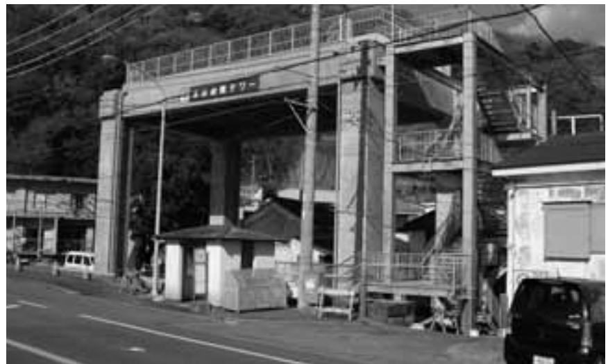
安心・安全な町 津波避難タワー整備
