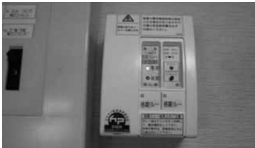
感震ブレーカー設置の一例（型式は様々な型式がある）
