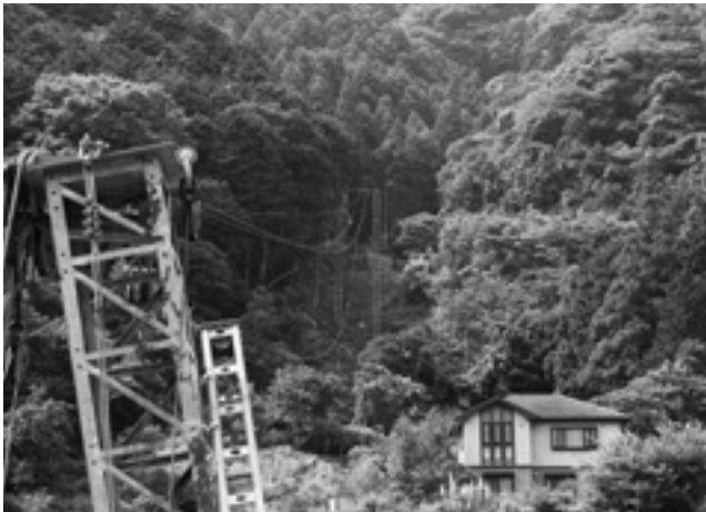
配水池工事中の写真
