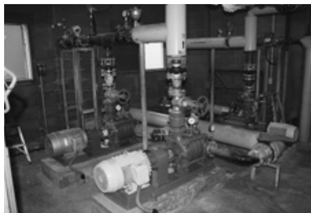
老朽化が進む温泉施設
