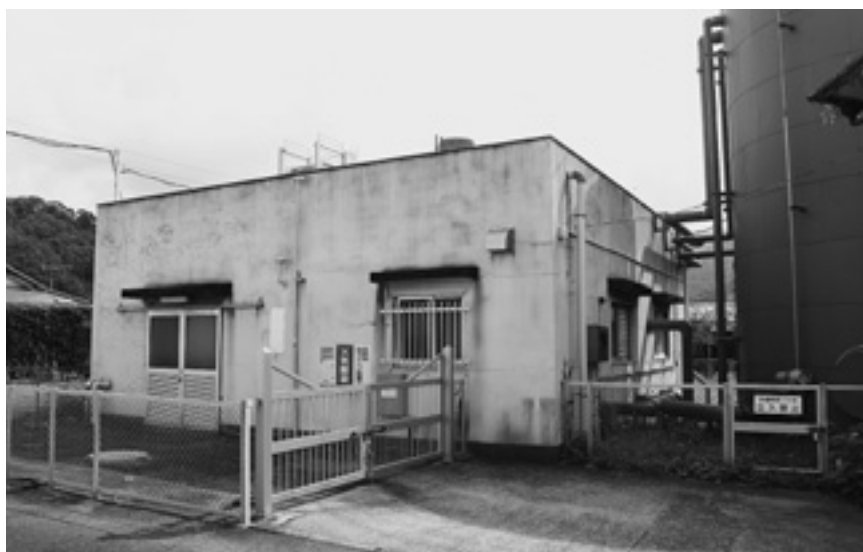
老朽化が進む温泉施設
