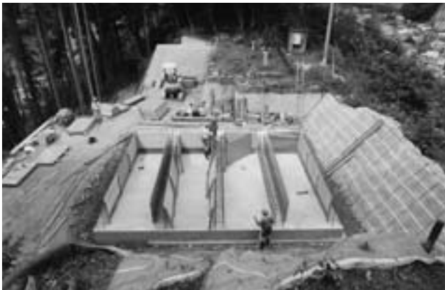
改修が進む赤池山配水池（安良里地区）
