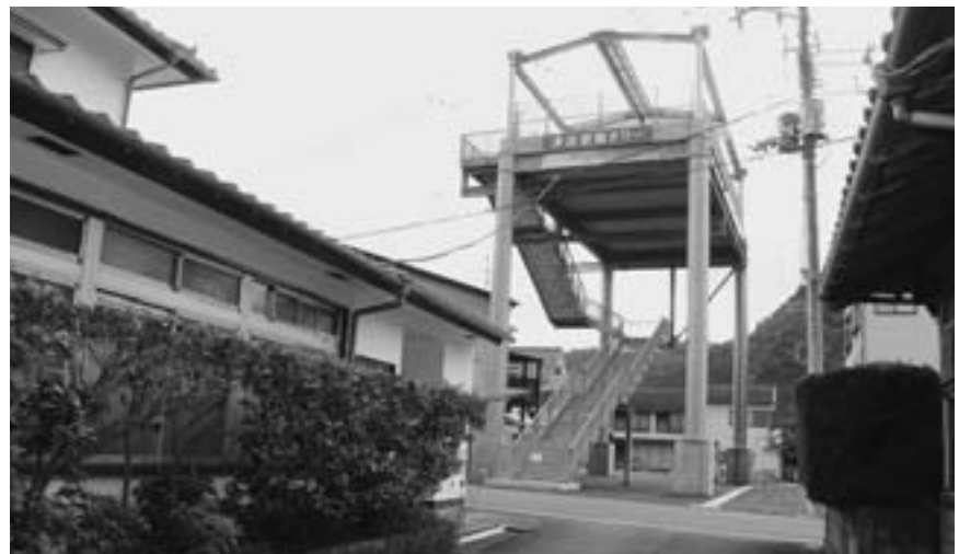
松崎町津波避難タワー
