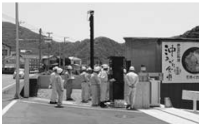
沢田 8 号陸閘新設工事
