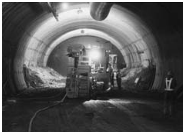
湯ヶ島第二トンネル工事
