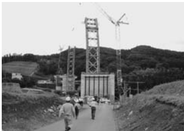
狩野川横断高架橋
