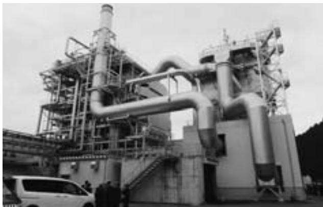
バイオマス発電所
